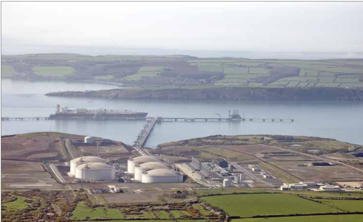
A view of the South Hook LNG Terminal.
